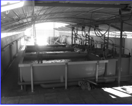
الشكل (6) نظام تدوير الاستزراع البحري (Mega Flow) في محطة العلوم البحرية/العقبة،
